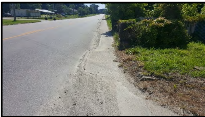
Figure 3-4: Deficient Sidewalk Infrastructure (N. York Street)
